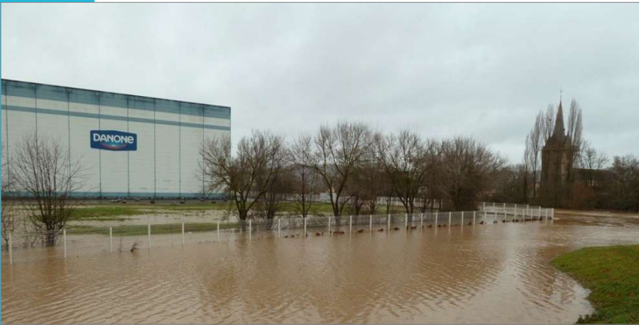
La laiterie de Danone à Villecomtal-Sur-Arros Cruel du 25 janvier 2014
